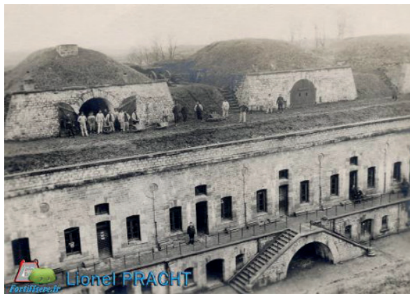
Le fort de Dampierre (ou Magalotti) à la fin de sa construction en 1878.
